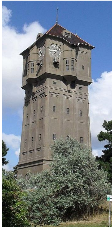
Watertoren IJmuiden circa 42 meter hoog, zeesluisdeur ruim 70 m
